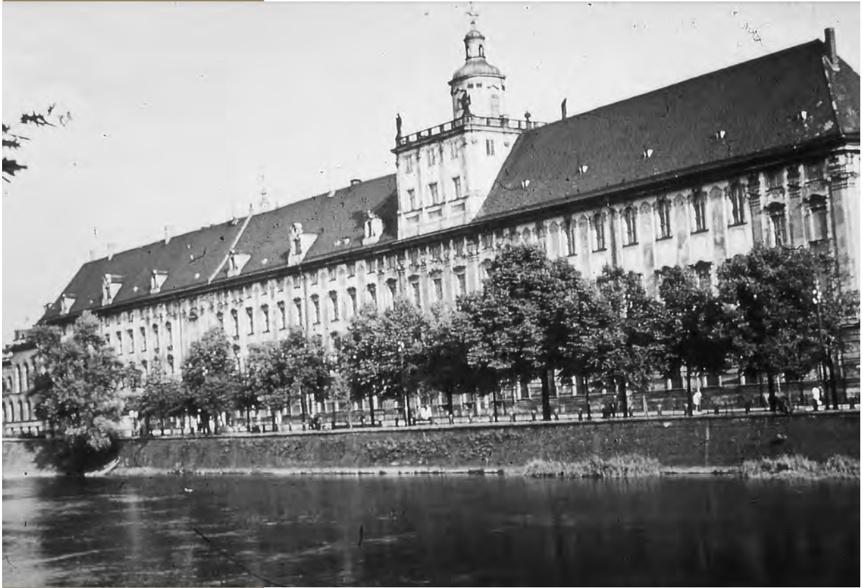
Schlesische Friedrich-Wilhelms-Universität zu Breslau, Main Building Source: private archive.
