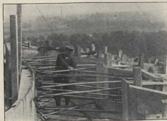
Fig. 81. Eisenbewehrung des Druckringes.
