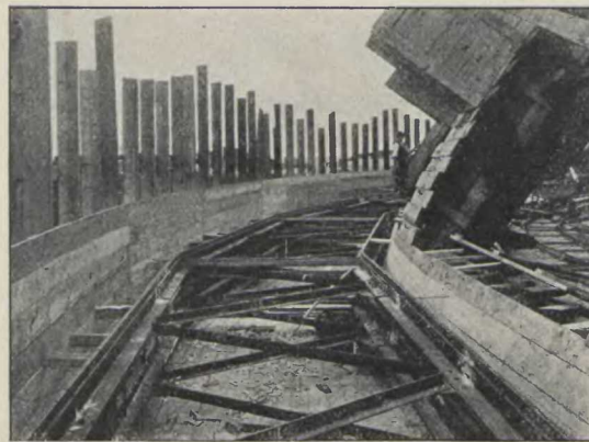
Fig. 80. Montage des Zuginnes der Kuppel.
