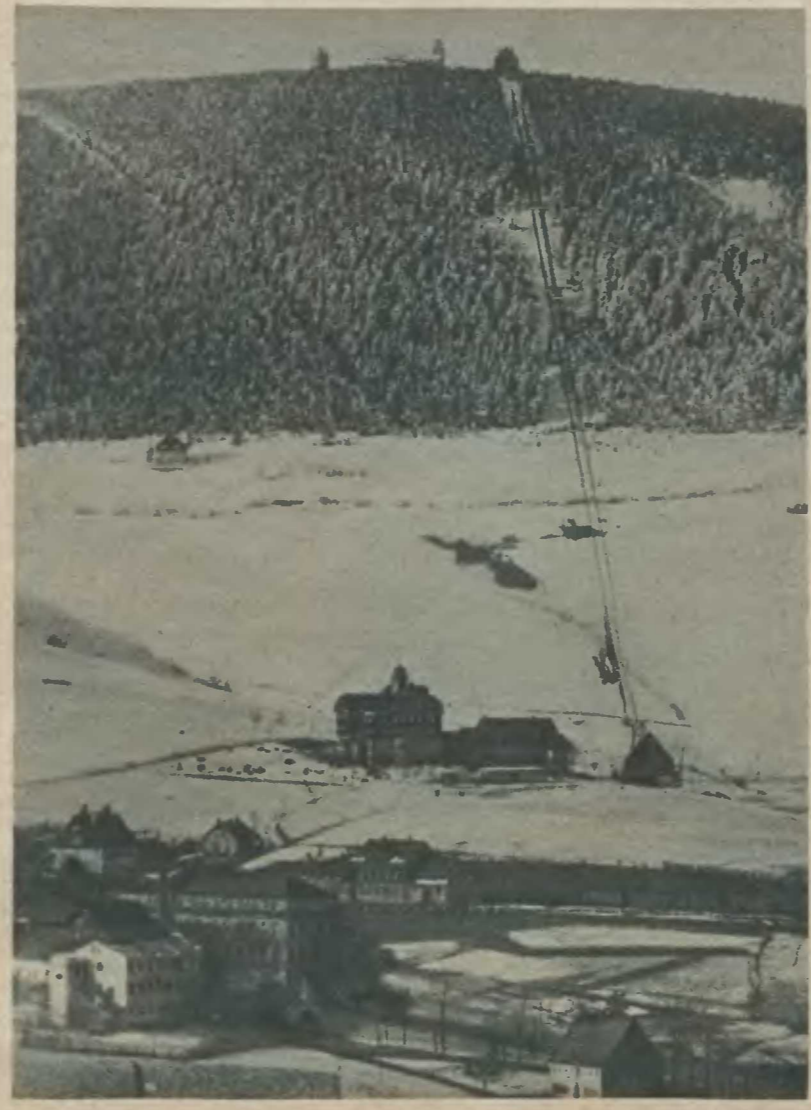
Die erste Personenseil-schwebebahn Deutschlands Am 20. Dez. wurde in Oberwiesenthal die erste deutsche Seilschwebebahn für Personenverkehr eröffnet. Die neue Bahn ist 1300 m lang und hat eine Steigung von 300 m. Sie befördert bei jeder Fahrt 12 Personen mit Sportgeräten in sechs Minuten von Oberwiesenthal auf den Fichtelberg. — Bild links: Bild auf Oberwiesenthal. Phot. Atlantic — Bild oben rechts: Die Einweihung der Personenseilschwebebahn in Oberwiesenthal. Photatlet
