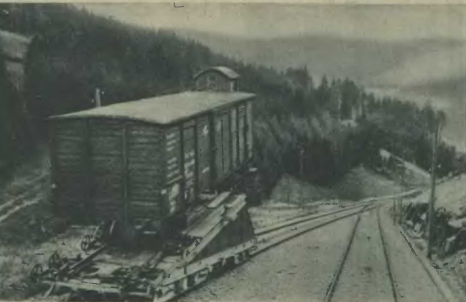
Ein Güterwagen auf der Oberweißbacher Bergbahn (bei Schwarzburg in Thüringen). Der Wagen wird auf ein Untergestell mit starkem Steigungswinkel geschoben, um den Wagen während der Fahrt in wagerechter Lage zu erhalten. Frank
