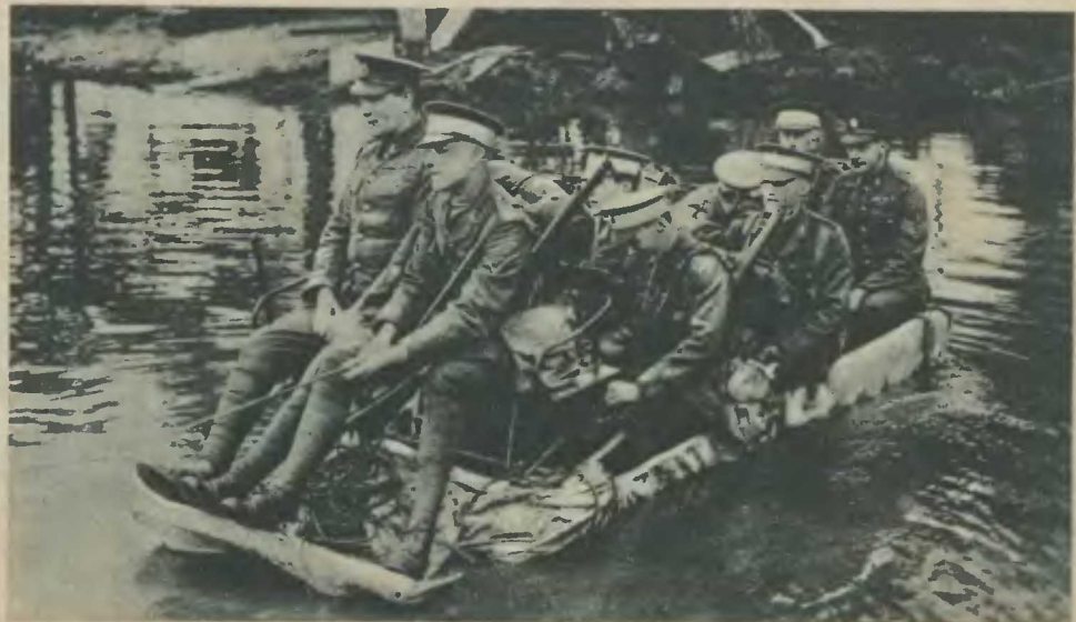
Zur Durchquerung kleinerer Gewässer werden in der englischen Armee die Wagen mit wasserdichten Überzügen versehen, sie können dann als Boote benutzt werden. Scherl
