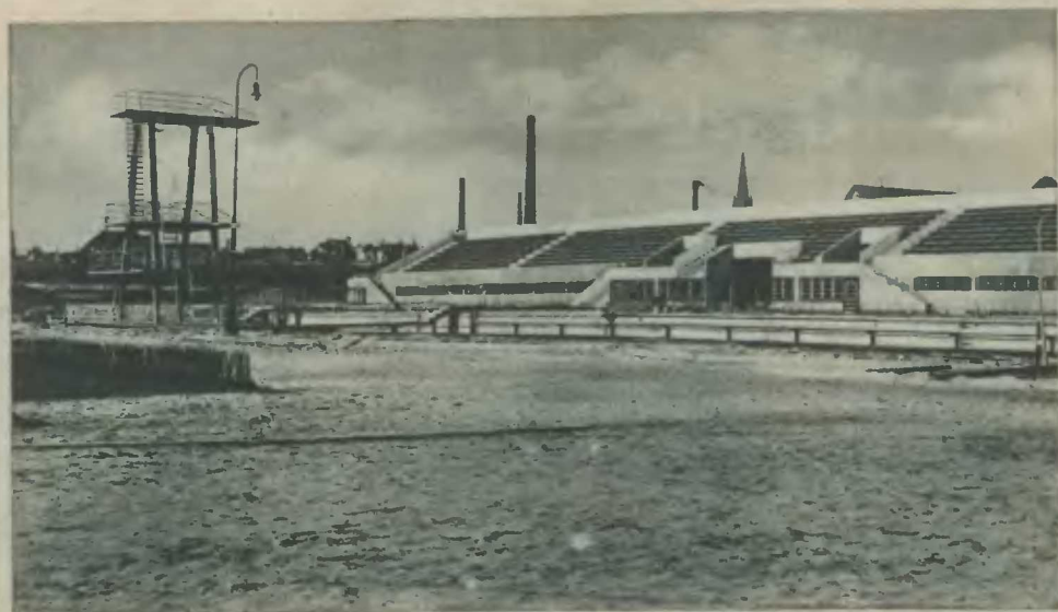
In Bielefeld wird demnächst ein Bad eröffnet werden, das im großzügigsten Stile erbaut und mit allen neuen Errungenschaften der Technik ausgestattet, zu den bedeutendsten Badeanstalten Deutschlands zählen dürfte. Vor einer über 1600 Sitzplätze gewährenden Tribüne sollen dort Vorkämpfe zum Schwimmländerkampf Deutschland—Schweden und zu den Europameisterschaften 1927 stattfinden. W. Bach
