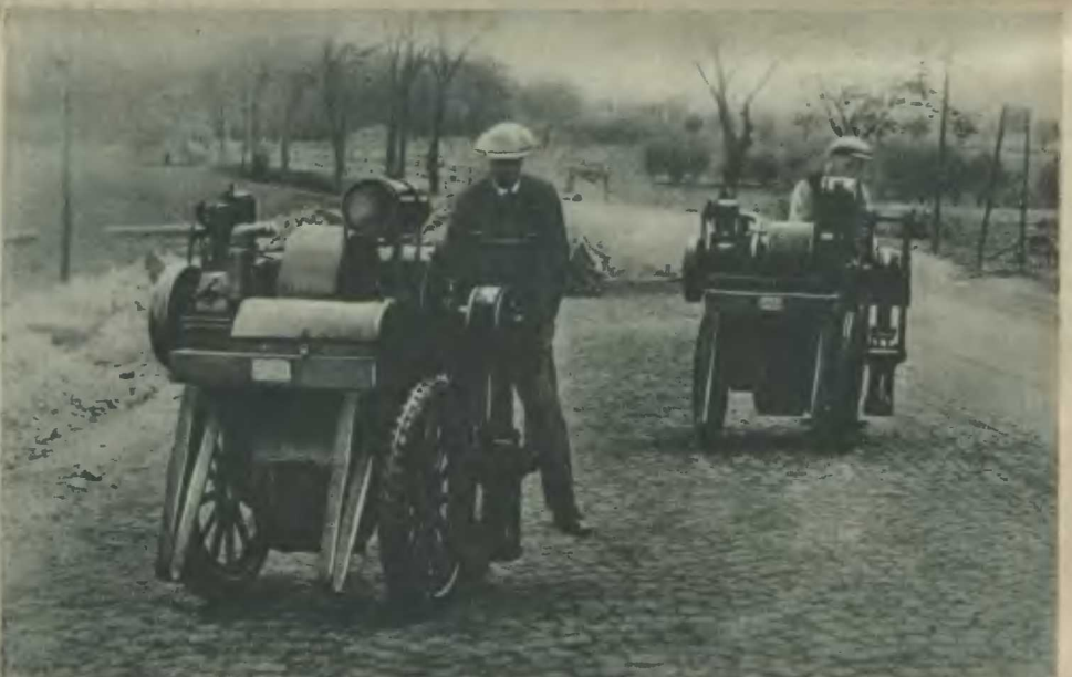
Eine neue Maschine für das Rammen von Pflastersteinen, die den Arbeitern diese schwerste Arbeit des Straßenbaues erleichtert. Atlantic
