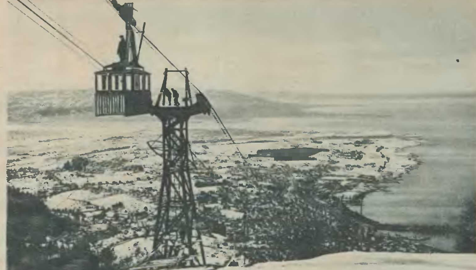
Die Kabine der neuen, kurz vor der Vollendung stehenden Pfänderbahn bei den ersten Probefahrten mit Blick auf Bregenz, den Ausgangspunkt der Bahn, und den Bodensee. Durch vier Klüften getragen, läuft diese Seilseilbahn mit zwei im Pendel- verkehr stehenden Kabinen in zwölf Minuten zu der 1040 Meter hohen Bergstation. Zennaro
