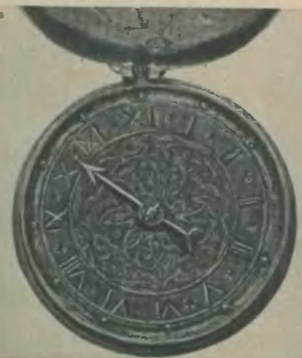
2. Die älteste bekannte Taschenuhr, ganz aus Eisen hergestellt. — Zeit 16. Jahrhundert. Vermutlich eine Arbeit des Peter Henlein, des Erfinders der Taschenuhren
