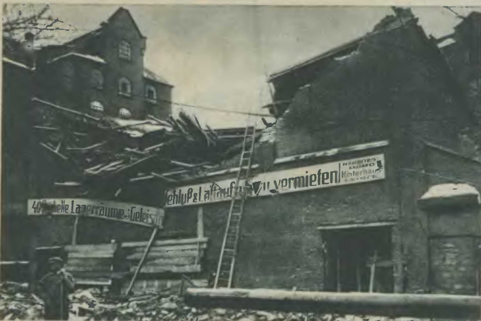
Kürzlich ereignete sich in Frankfurt a. M. ein Hauseinsturz, bei dem vier Menschen ums Leben kamen und eine Anzahl weiterer Personen teils schwer, teils leicht verletzt wurden. Unser Bild zeigt die Unglücksstätte. Wieder
