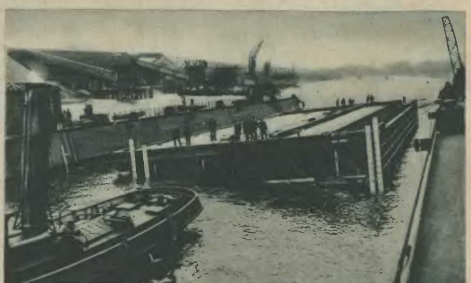
Eines der größten Schleusentore der Welt, das in einer die niederländische Stadt Zimuiden mit der Nordsee verbindenden Kanalschleuse verwannt werden soll, wurde nach seinem Bestimmungsort übergeführt. Es ist 53,5 Meter lang, 8,4 Meter breit und 20,4 Meter hoch und hat ein Gewicht von ungefähr 1 Million 200.000 Kilogramm. Atlantio
