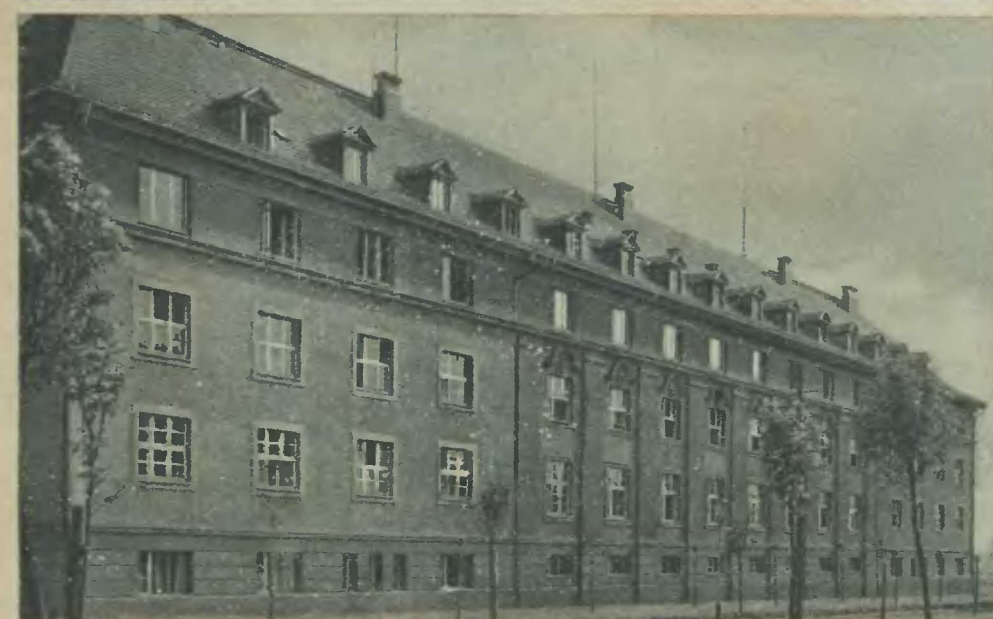
Bilder links und rechts: Die Polizeiunterkunft in Hindenburg, Ober- schlesien, erbaut vom Preussischen Hochbau- amt Beuthen, Ober- schlesien (Regierungs- baurat Weyrauch) Hof. Heinrich Klett. Breslau
