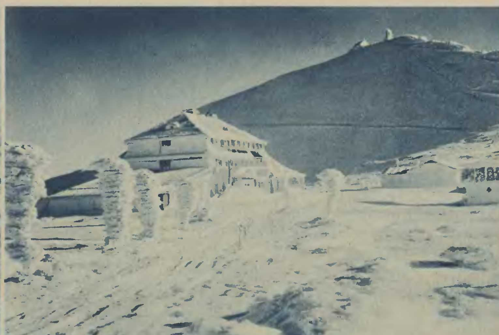
Das Schlesierhaus mit Schneekoppe
