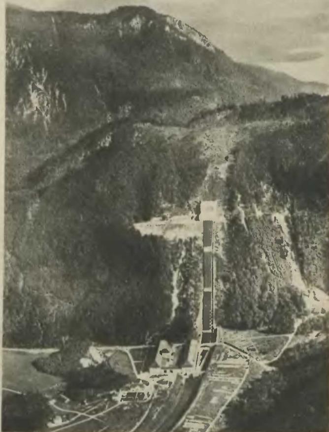
Das Walchenseekraftwerk aus der Vogelschau, das mit der aus dem Wasser des 200 m über dem Werk befindlichen Walchensees gewonnenen elektr. Energie fast ganz Süddeutschland versorgt.
